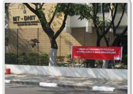
Fachada da Superintendência em São Paulo
